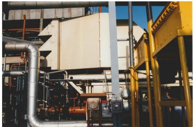
ASE40 燃气轮机驱动一个离心式燃气压缩机，持续运行。
