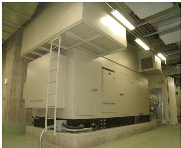
ASE40燃气轮机的使用，有效的替代昂贵的电网电源，同时将发动机排放的余热转化为办公楼所需要的冷源与热源。
