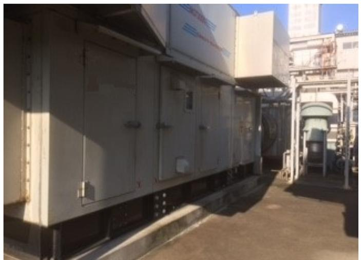
ASE50燃气轮机的使用，有效的替代昂贵的电网电源，同时将发动机排放的废热转化为饮品生产所需要的热源。
