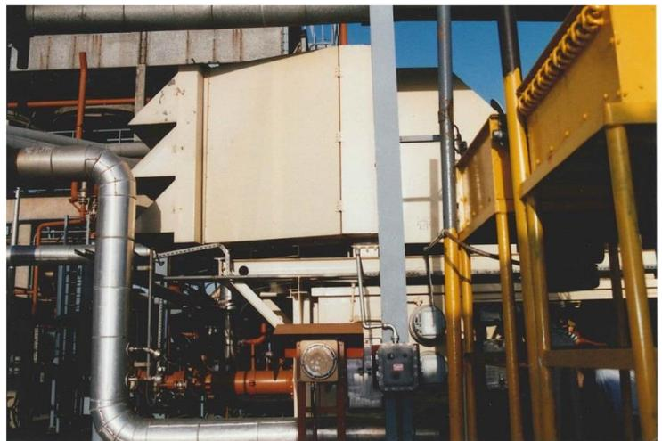
La turbina de gas ASE40 acciona un compresor centrífugo de gas operando de forma continua.
